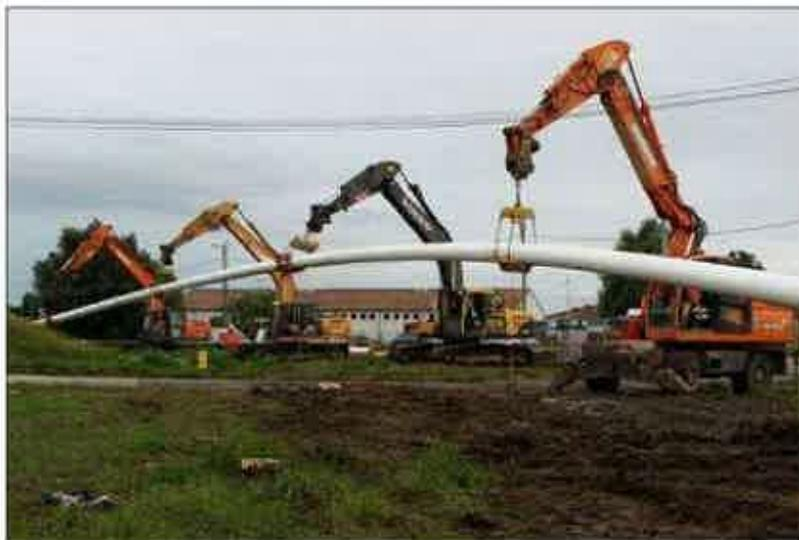
Figure 15 : Exemple d'une mise sur caténaire
